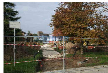
Sono ripresi i lavori...
